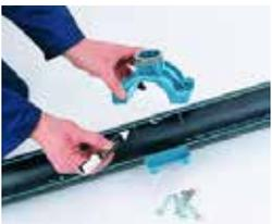
Das Rohr anbohren und die in der Rohrleitung durch das Anbohren entstandenen Verunreinigungen aus dem Rohr entfernen
